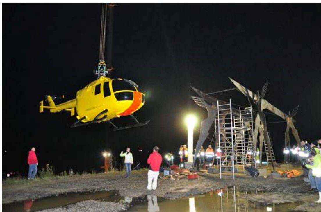
Die BO erreicht den Hügel, anschließend werden die Rotorblätter montiert
